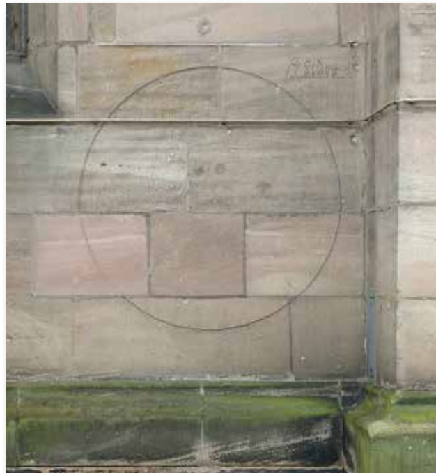
Der „Glockenkreis“ mit einem Durchmesser von 1,43 Meter im Mauerwerk der Peterskirche.
